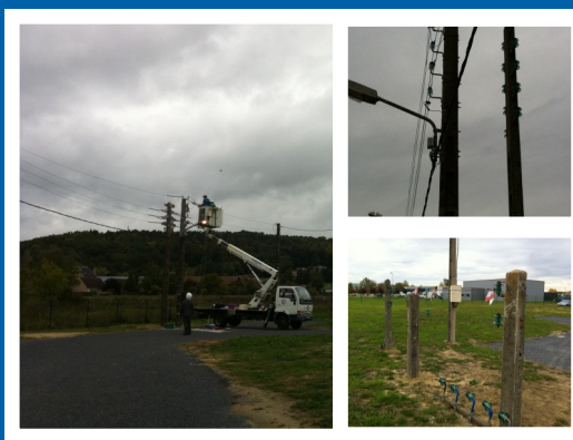
Réalisation d'un réseau aérien tout type de câbles et branchements aériens
